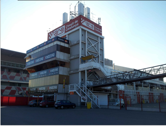
8 Torre de Control
